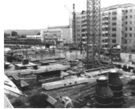
Bau der Kinderklinik, 1975
