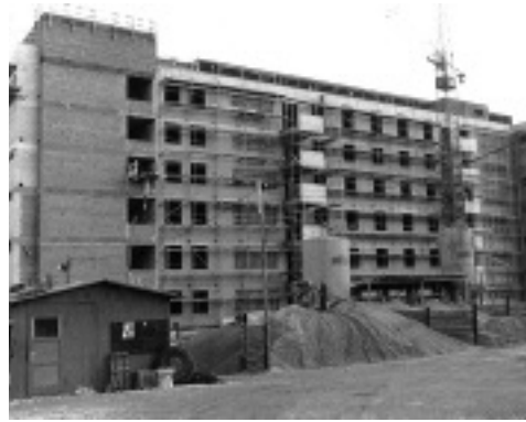
Bau des Bettenhauses West, 1968
