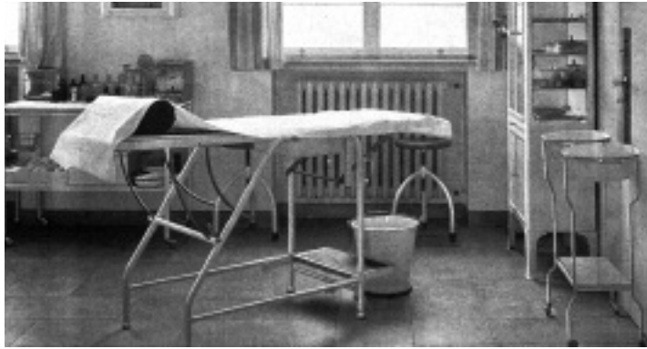
Chirurg. Abt., asept. Vorbereitungsraum, 1930
