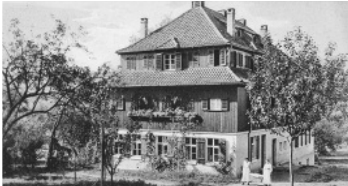
Nebengebäude in Kennenburg
