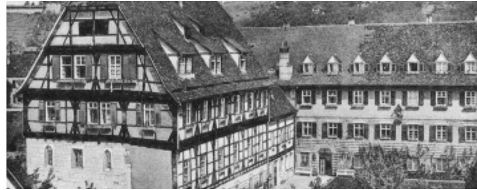
Ehemaliges St. Clara Hospital, um 1925
